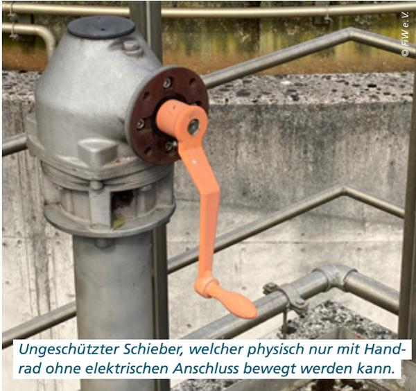
*Ungeschützter Schieber, welcher physisch nur mit Handrad ohne elektrischen Anschluss bewegt werden kann.*
