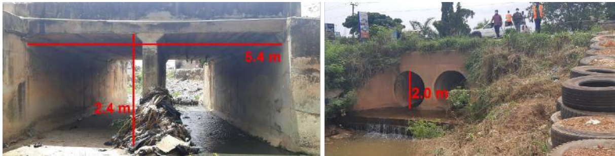
Abbildung 8: Durchlässe inklusive Abmessungen zur Abschätzung der Querschnittsfläche.
