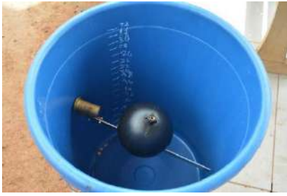
Abbildung 61: Wasserstandskontrollbehälter mit Schwimmerventil (R. Voß).
