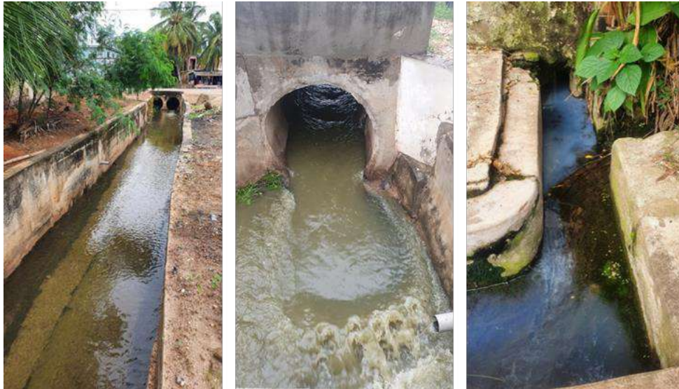
Abbildung 57: Abschnitte des Onyasia z.T. mit Einleitung (graue Rohre) von Haushalten (S. Krüger).
