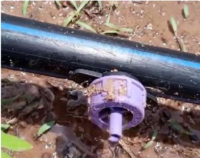
Abbildung 102: Palaplast-Einzeltropfer eingesteckt in 20 mm HDPE-Leitung
