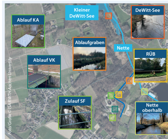
Probenahmestellen auf der Kläranlage Nette, sowie am Vorfluter Nette.
