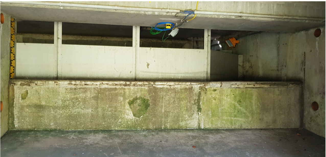
Sonde und Probenahmeschlauch an Entlastungsschwelle. © FiW e. V.
