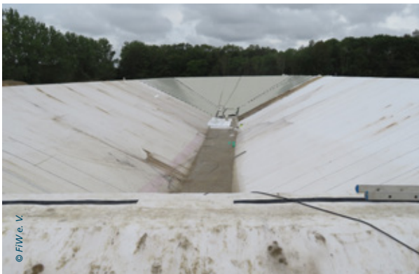
Beispiel Langzeitwärmespeicher in Dänemark im Bau.
